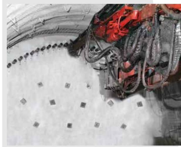
Frequentemente le gallerie attraversano terreni fratturati e incoerenti, per garantire la stabilità della volta si devono eseguire in calotta degli infillaggi con funzione stabilizzante, costituiti da tubi in acciaio di vario diametro.
